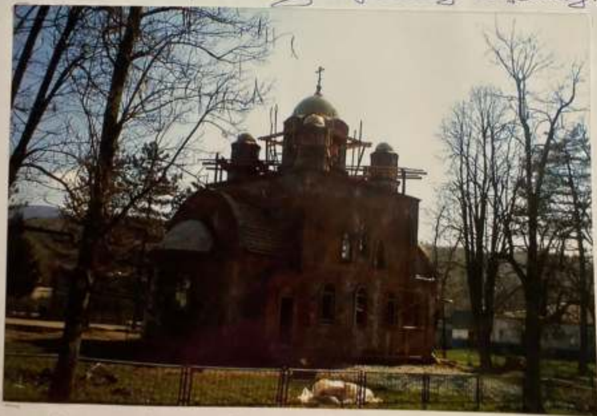
Строительство Свято-Георгиевского храма. Фото Лукьяненко Т.А. 04.2010 г.
